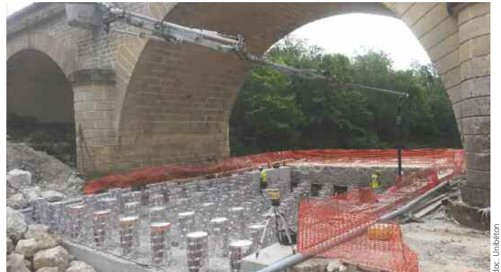
Mise en œuvre par pompage.
